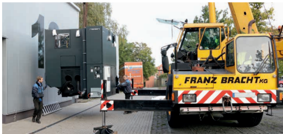
Foto: Bei der Anlieferung der neuen Anlage war Maßarbeit gefragt.
