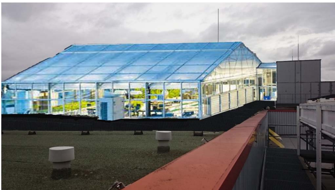
Abb. 40: Dach des Warenhauses mit möglichem Gewächshaus
