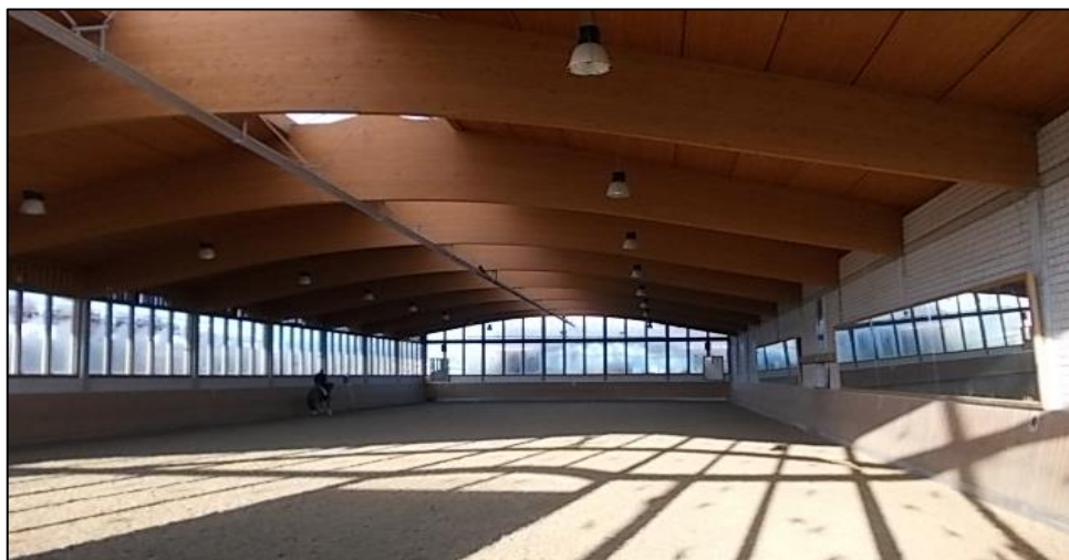
Abbildung 82: Innenansicht Reithalle der Hofstelle Rhenania Reitsportzentrum Baldeney
