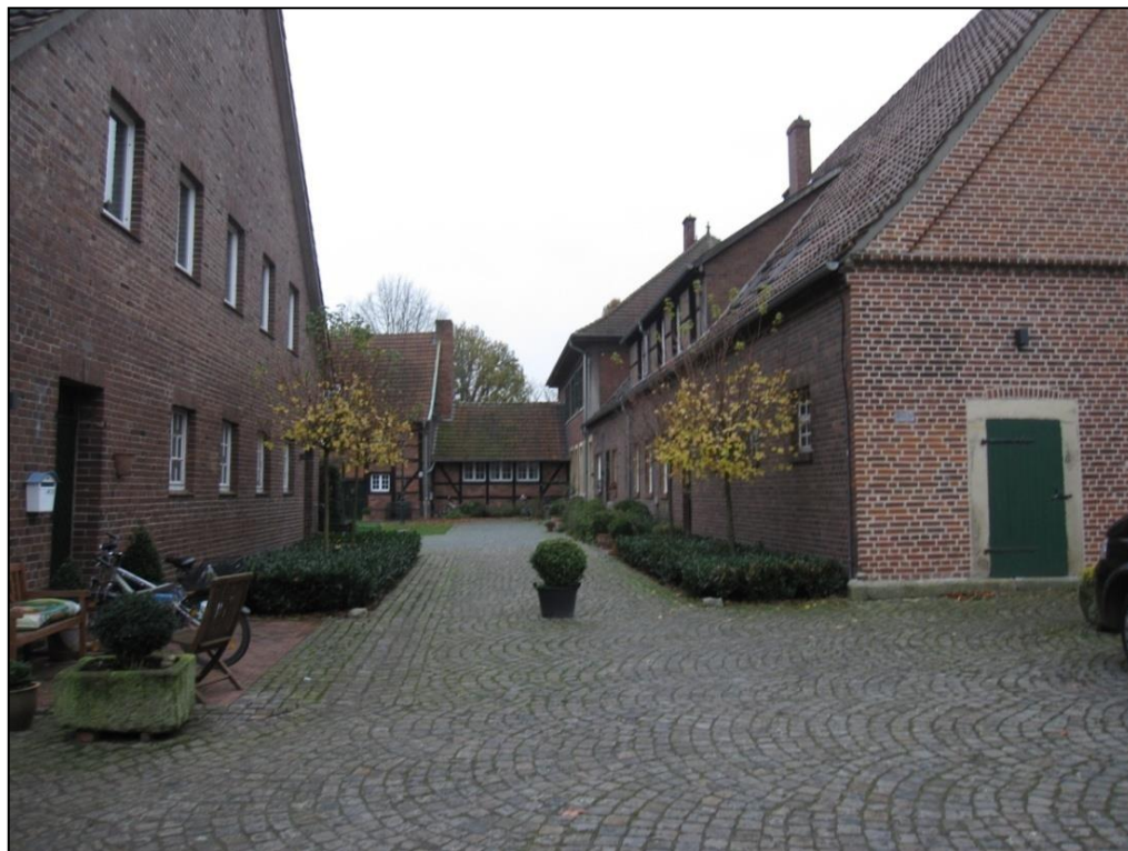
Abbildung 44: Betriebs- und Wohngebäude der Hofställe Bioland Hofgut Schulze Buschhoff
